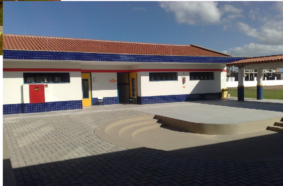
OBRA EM ANDAMENTO
