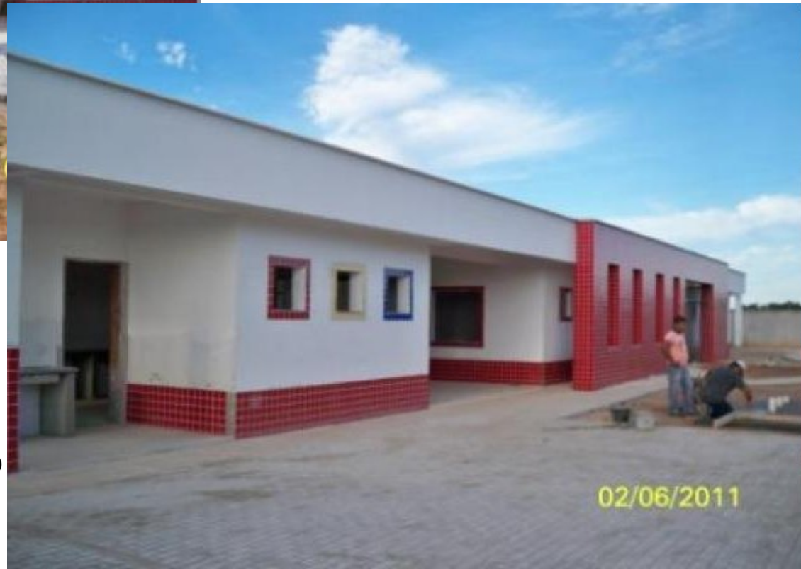
OBRA EM ANDAMENTO
