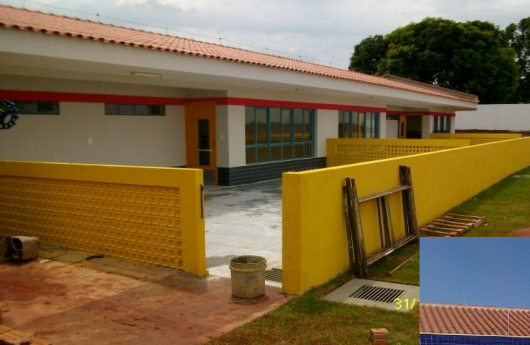
OBRA EM ANDAMENTO
